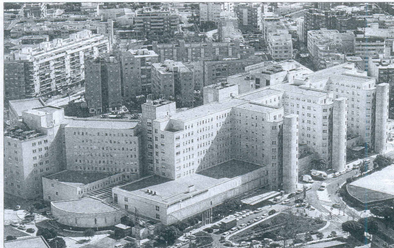
Sanidad abrirá la puerta a la entrada de gestores privados en los hospitales. RAFA ARJONES
